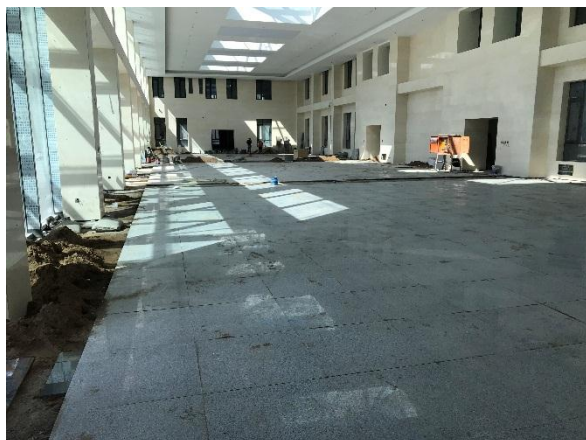
大厅石材铺装
