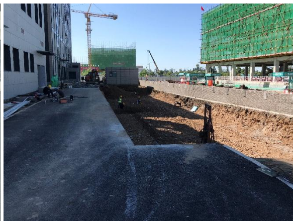
开闭站基坑挖槽放线
