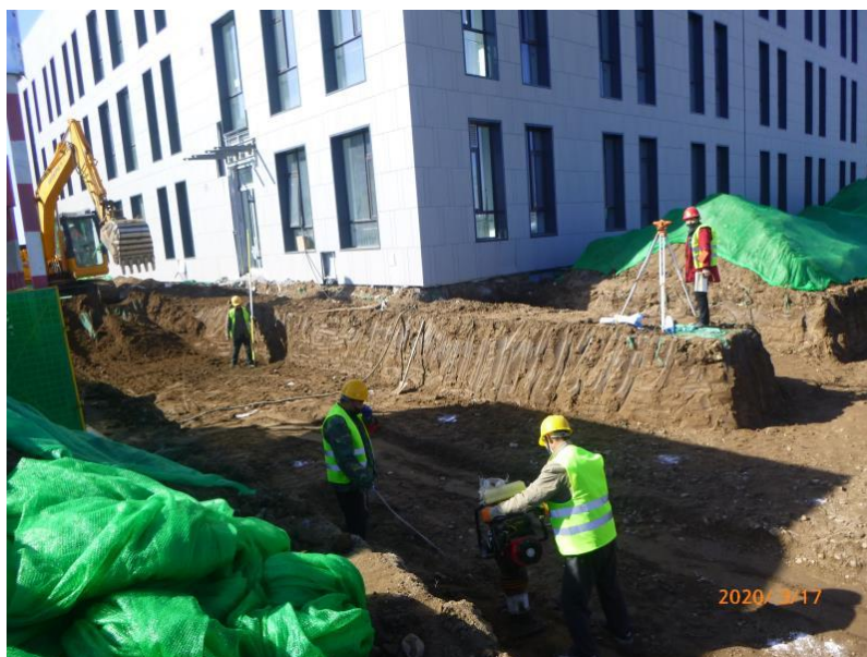
外线施工管沟开挖
